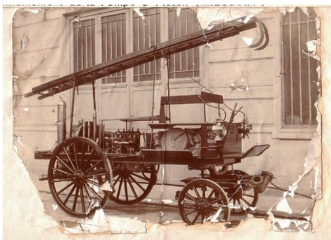
Fig. 11 : Voiture incendie hippomobile dotée d'un moteur auxiliaire pour l'entraînement de la pompe à piston Miesusset.
