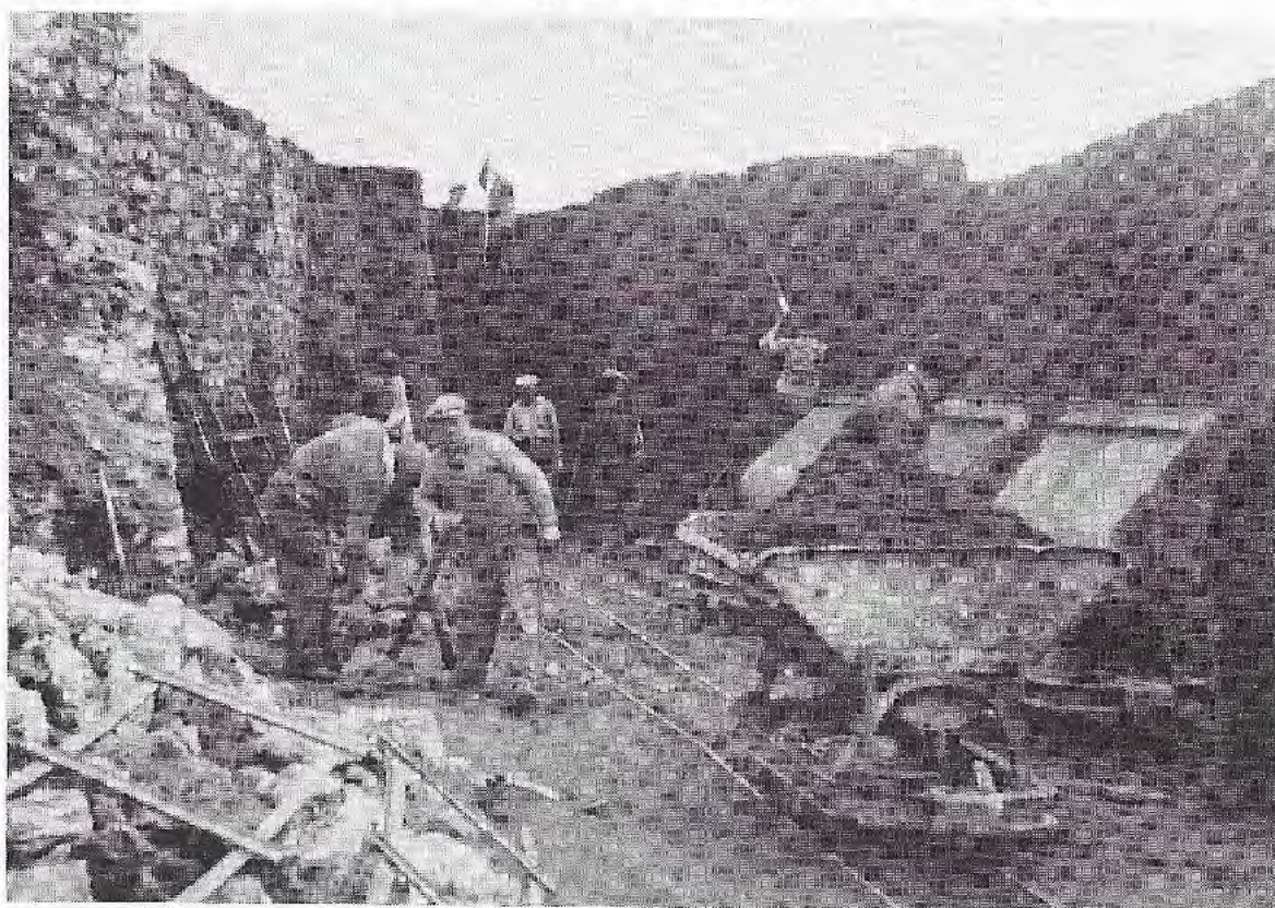
La route d'accès fut réalisée à partir du printemps 1935 dans le flanc même du coteau : en face du pont Jacquard, il fallut démolir d'anciens bâtiments (en bas, à gauche). [Photos Gigli, Coll. R. Chaumartin]
