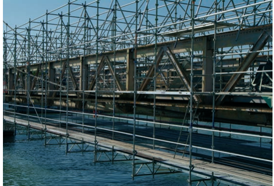
Fig. 5 : La passerelle de Sainte-Colombe : la structure métallique du confinement en cours de montage [Cliché R. Lauxerois].
