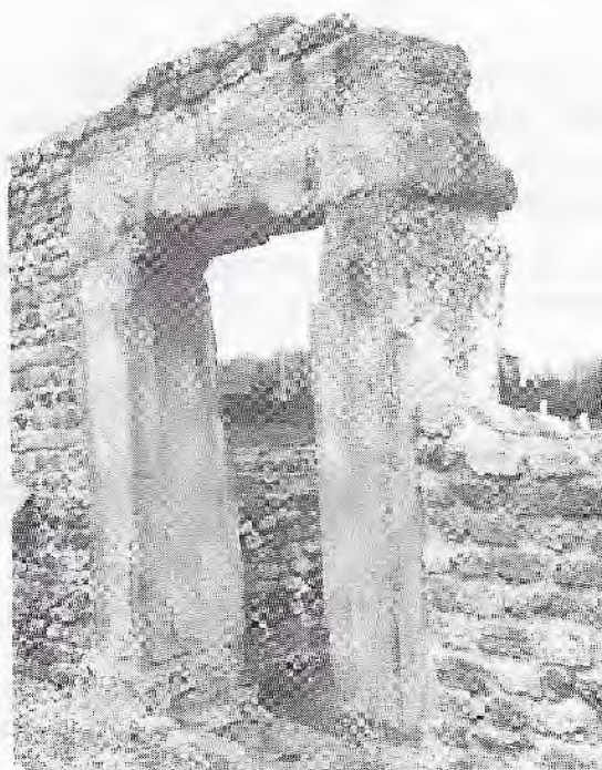
Fig. 3 - Petits entrepôts : seuil et encadrement d'une porte de boutique en molasse.
