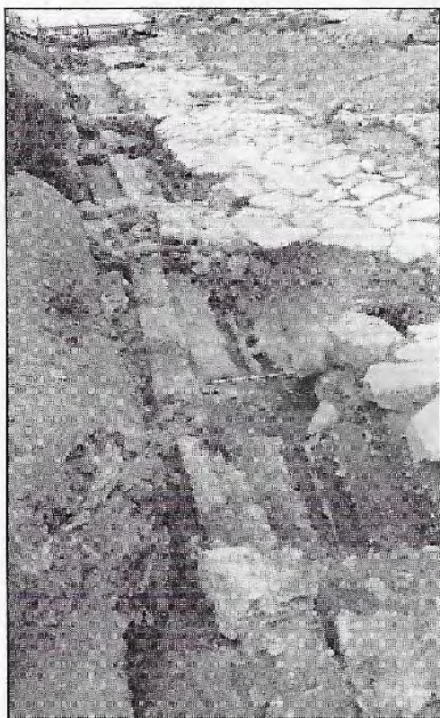
3- Rue des Thermes, côté ouest. Le long de la façade, le trottoir maçonné (conservé très ponctuellement) recouvrait deux tuyaux d'adduction d'eau en bois.
