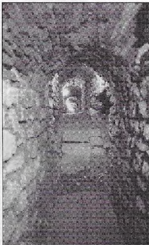
4- Vue de l'extrémité de l'égout du I er s. construit sous la rue des Thermes. Au delà, une section plus petite a été aménagée plus tard (II e s.) à un niveau supérieur. Leur raccord s'effectuait par un pan incliné.
