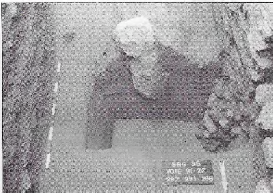
1- Sondage dans la rue des Thermes (Voie III 27). Le bloc de pierre planté dans les alluvions du Rhône marque l'angle d'une parcelle délimitée dès la fin du I er s. av. J.-C.. A droite, la fondation en galets du bâtiment le plus ancien. Sur la gauche, le premier niveau de chaussée en gravier.
