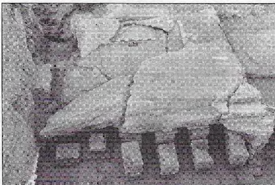
18- Thermes des Lutteurs, pièce 23, détail de la piscine centrale sur hypocauste. En haut et à gauche, l'entrée du foyer. Des piliers de briques ont été substitués aux pilettes pour supporter la masse de la suspensura.
